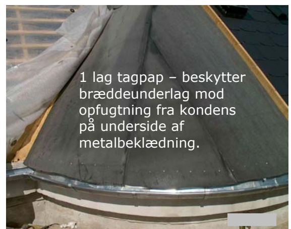
Ovenpå brædderne, som underlag for zinkbeklædning, blev påsømmet tagpap, og derefter Deltadug, for at kondensdannelse på bagside af zink kan bortventileres.
