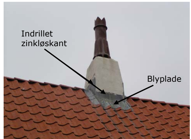
Specialskorsten, med tilslutning til tagflade med indrillet zinkløskant og blyplade banket til tagteglsten.
