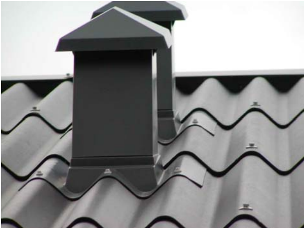
Udluftningshætter af plast, monteret i B5 bølgeeternit i 2 fods- plader.
