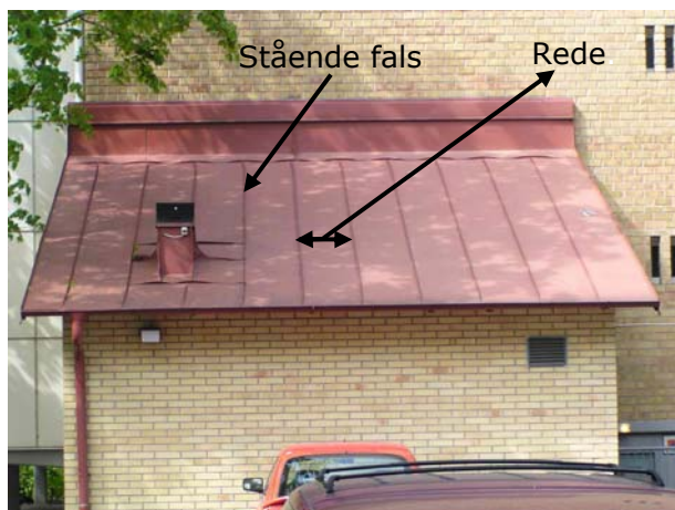
Metaltag med stående false og reder - i korrugeret kobber. Tagbeklædning fastholdes med hafter på faste plader (xfinér) el. brædder. Lang levetid kan påregnes.
