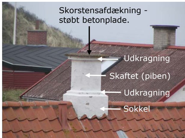
Skorsten i pudset, hvidkalket murværk. Ved skorstensfod er der pudset til tagbeklædning af tagteglsten, type vingetegl.
