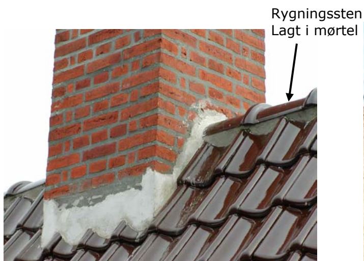
Skorsten i blank mur. Skorsten er sat i tagrygning, og den oppudsede sokkel tilslutter tagbeklædning af glaserede tagteglsten.
