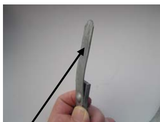
Forfjeder på rendejern bøjes om vulstforkant (hér en maskinvulst) på tagrende.
