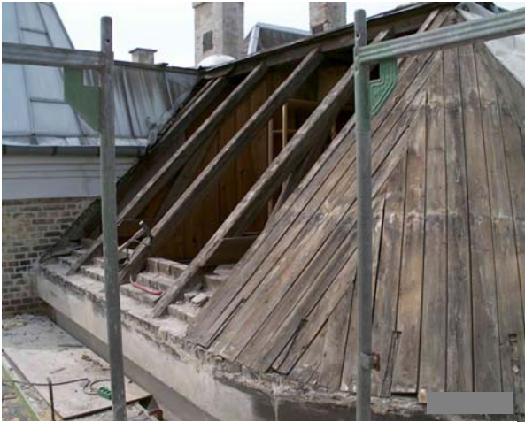
Underlag (sammenskårede brdr.) for buet zinktage (metaltage).
