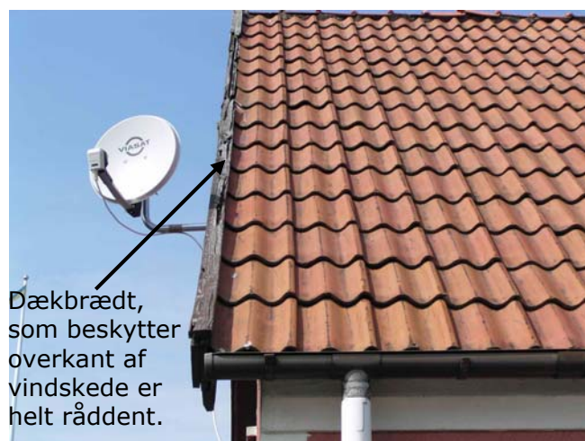
Lille udhæng i facade og ved gavl.
