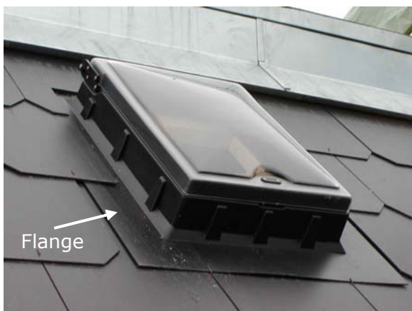
Nyt tagvindue af plastik. Tophængt og med udskyderstang forneden.
