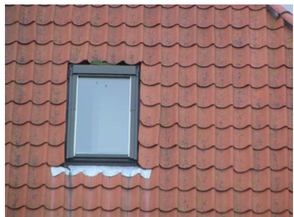
Velux ovenlys ilagt tag med tagbeklædning af tagteglsten - vingetegl.
