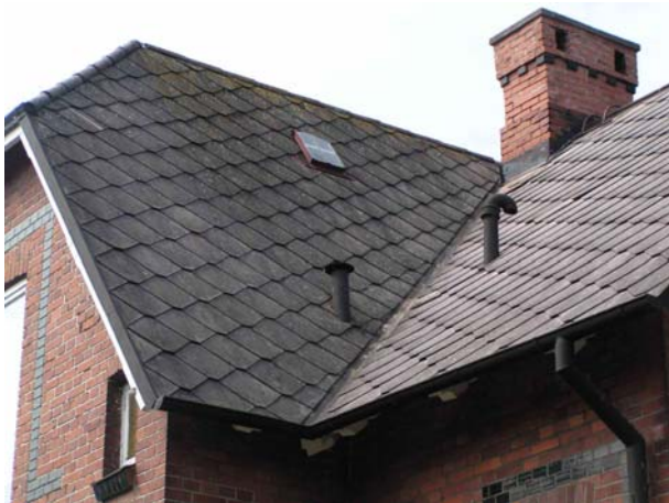
Eternitskifertag af fiberarmerede cementplader (eternitskifer) - diagonale skifre. Tagbeklædning fastholdes med hullokning og sømning, + evt. kit. Ikke særlig langvarig levetid.
