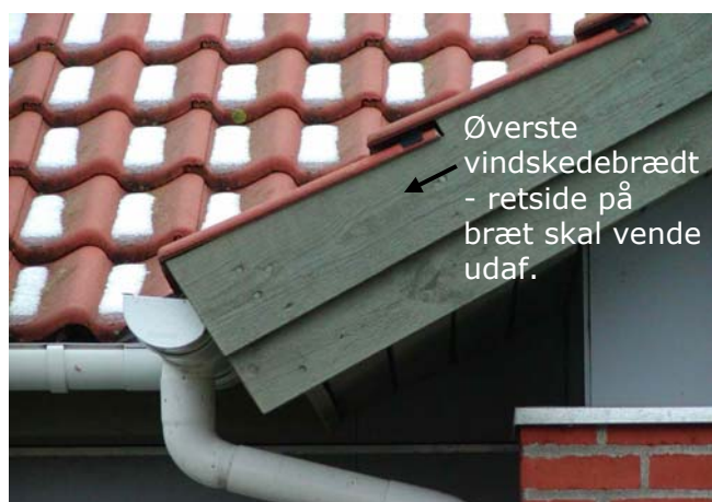
I gavls øverste vindskedebrædt er der nedfældet tagsten.
