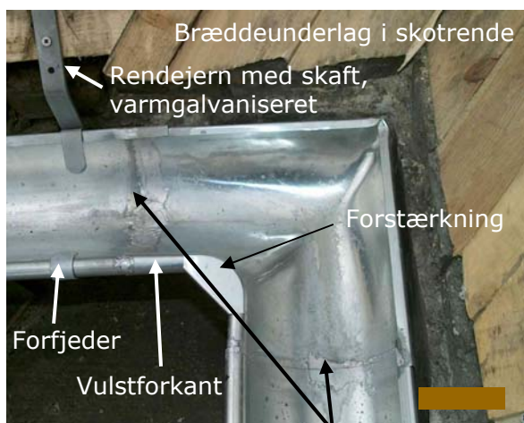
Tagrendehjørne (gehring) sammenloddet med tagrender, for enden af en skotrende.
