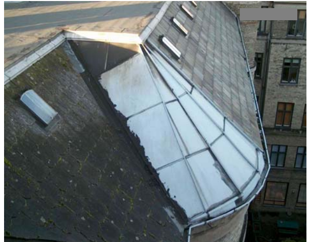
Ældre buet zinktage ligger på tagpap ovenpå de sammenskårede brædder.
