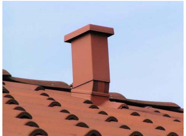
Udluftningshætte (justerbar i vinkel) af plast, monteret i betontagsten.
