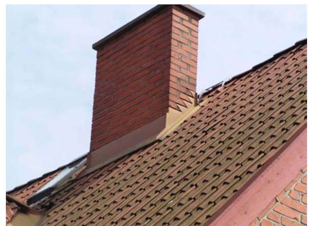
Skorsten i blank mur, med tilslutning til tagflade med aftrappet zinkløskant af svensk type.
