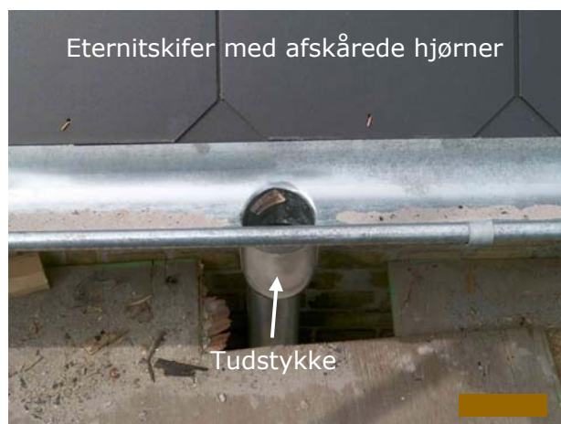
Zinktagrendes hul (med tudstykke) for nedløb. Tagrender og nedløb kan udføres i: Galvaniseret stål, Aluminium, Kobber, Zink og Hård PVC.
