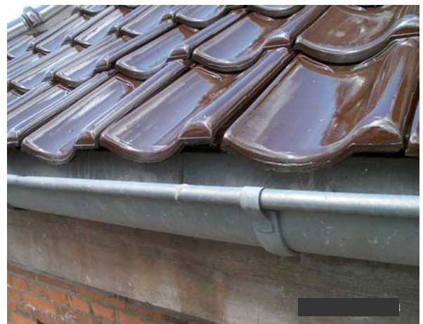
Glaserede tegltagsten tæt på. Den glatte overflade giver hurtigere vandafledning, men glaserede tegltagsten suger ikke vand, ligesom snavs ikke hæfter godt på glasuren.
