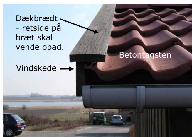
Mellemstort udhæng i gavl.
