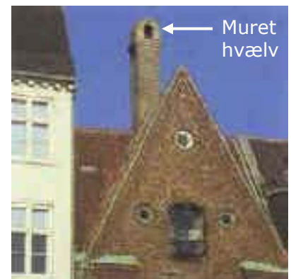
Skorstenspipe med tag udført som muret hvælv. Piben er meget høj pga. den tæt ved stående høje nabogavl.
