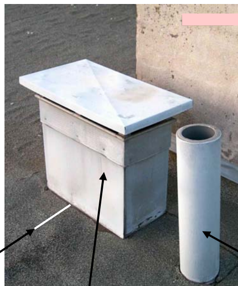
Ældre zinkudluftningshætte (køkken/bad) og zinkfaldstammeudluftning (WC).
