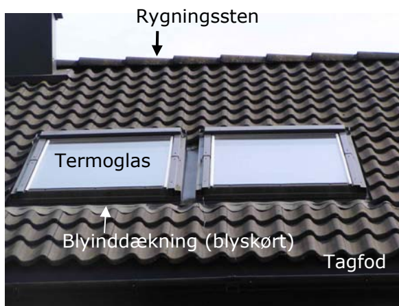
Velux ovenlys ilagt tag med tagbeklædning af betontagsten.
