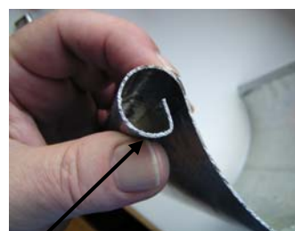
Forfjeder på rendejern bøjes om vulstforkant (hér en maskinvulst) på tagrende.
